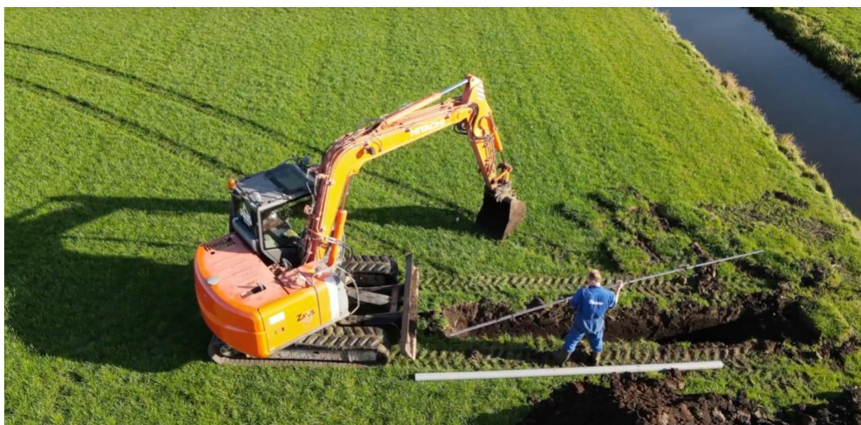
Afbeelding 3. Aanleg van een verzamelput voor de buizen. Foto: uit Netvlist aflevering 3, Alma Producties.
