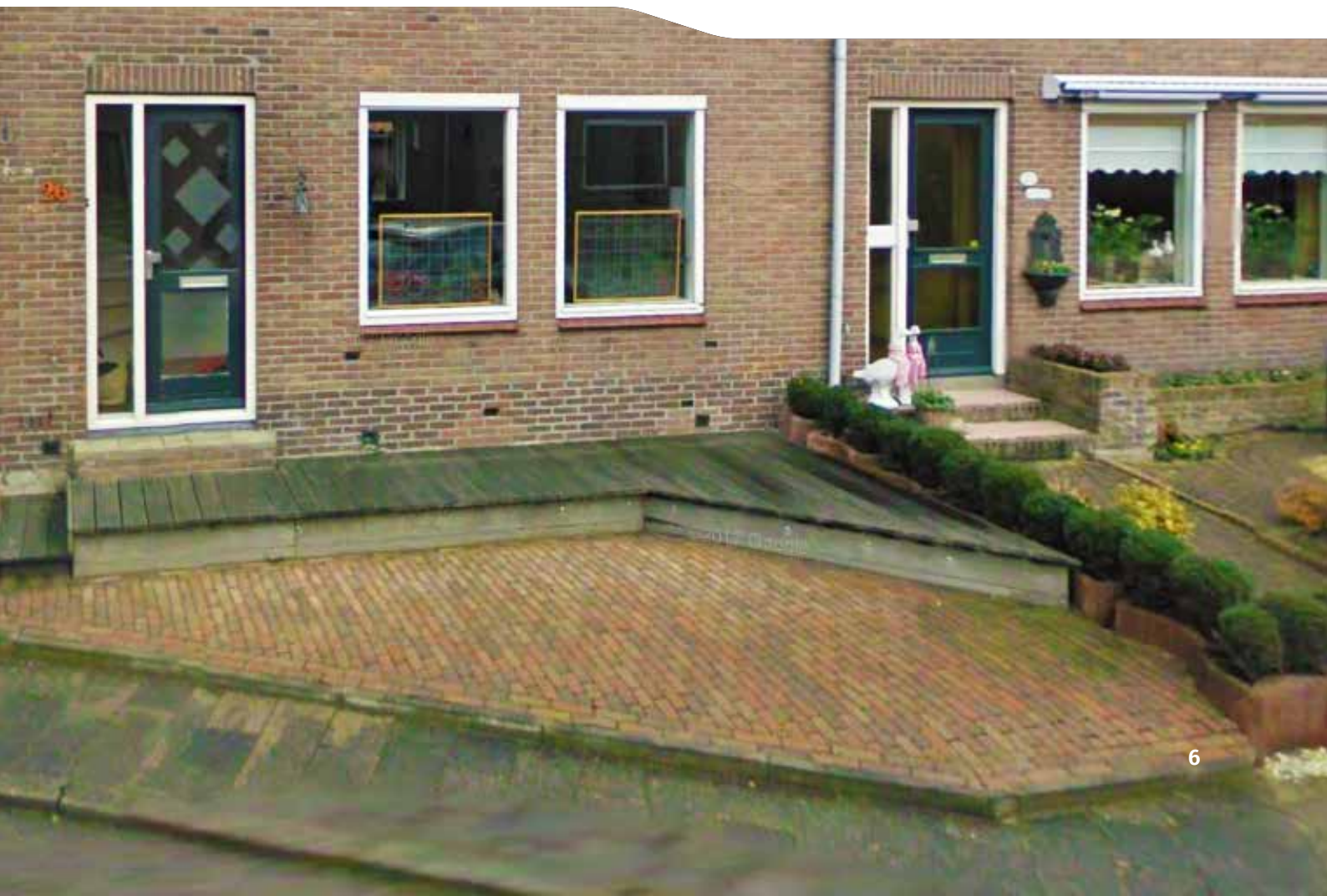
Figuur 1. Hoogteverschil dorpel en stoep is duidelijk zichtbaar door de treden in de voortuin (Kanis, gem. Woerden)
