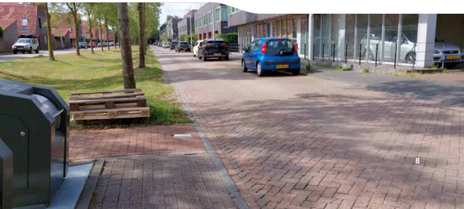
Figuur 5: Verzakkingen in Utrecht door zware voertuigen (Foto: Floris Boogaard, www.climatescan.nl/projects/1006/detail )
