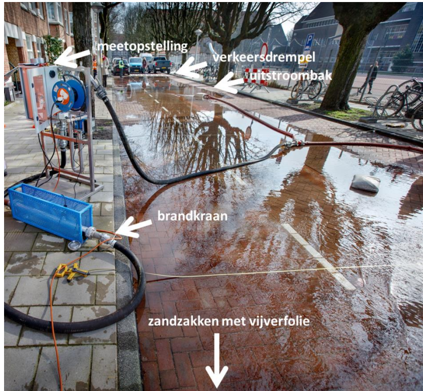
Figuur 19 Afgesloten gedeelte van de Argonautenstraat tijdens de infiltratieproeven van de Granudrain.
