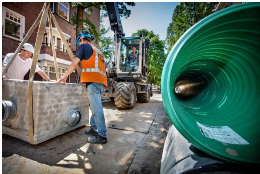
Figuur 15 Het DIT riool tijdens de installatie in de Argonautenstraat.
