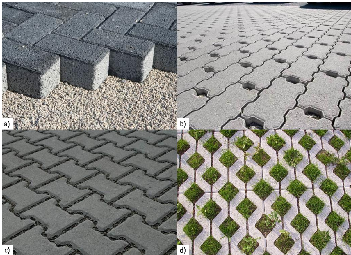
Figuur 4 (a) Poreuze betonstraatstenen (Straategie, 2017); (b) betonstraatstenen met drainagevoegen (Stradus Infra, 2011); (c) betonstraatstenen met verbrede voegen (Stradus Infra, 2017); (d) grasbetontegels (Wikimedia Commons, 2007).
