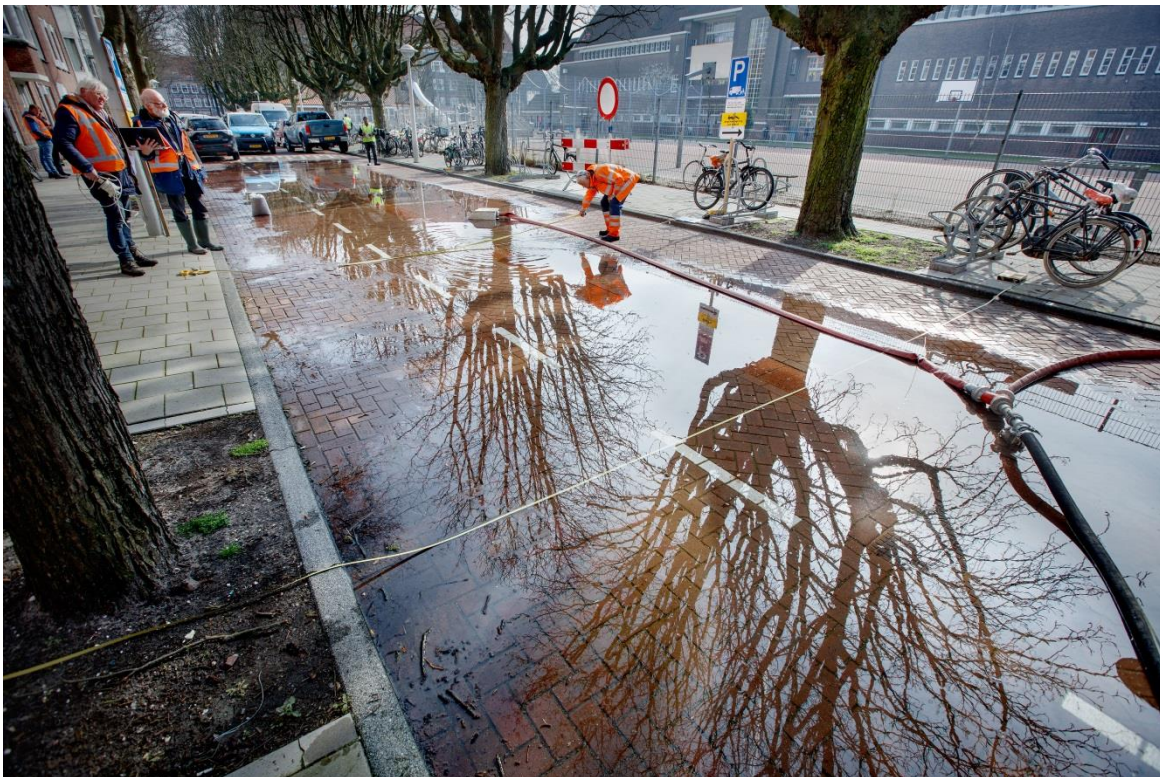
Figuur 21 Impressie infiltratieproeven met de Granudrain (Waternet, 2016).
