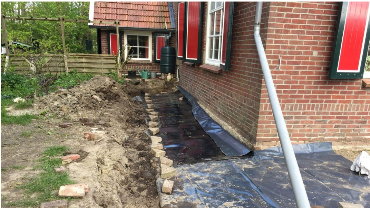
Afbeelding 4: aanbrengen HDPE-geomembraan
