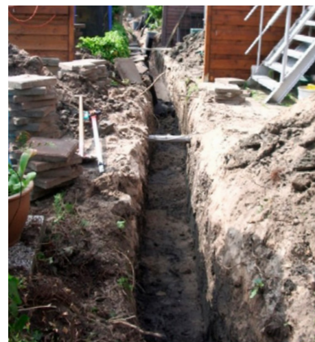
Aanleg DI-leiding in de achtertuinten aan de Krommedijk (2010)
