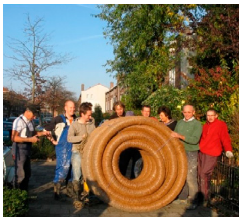
Aanleg DI-leiding kruipruimte Heysterbachstraat (2011)
