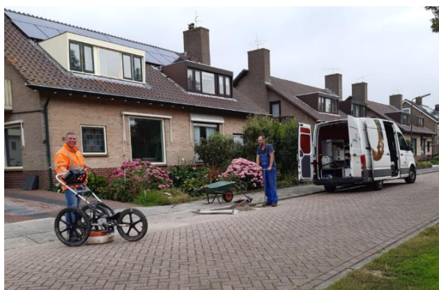
Afbeelding 3.1: Radarmetingen en uitvoeren verificatieboring Julianalaan Zegveld
